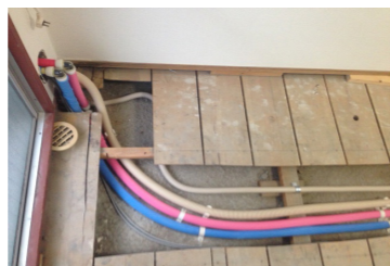
ベランダ給湯器への配管 配管口は箱状の造作で隠蔽
