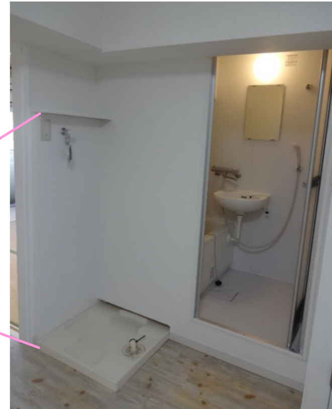
洗濯機配管勾配取れば、洗濯機パン下高上げしません。
